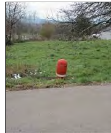
Poteau d'Incendie AN-3 situé à Andilly
